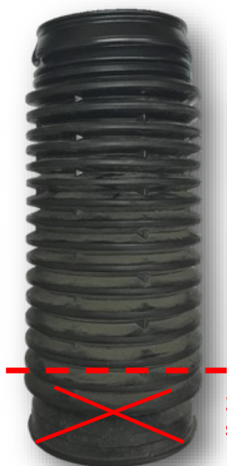
Abb. 2: OE-Schutzrohr kürzen
